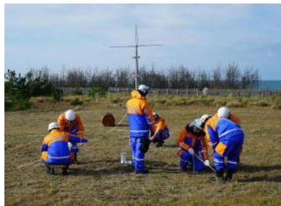
通信設備の設置訓練
