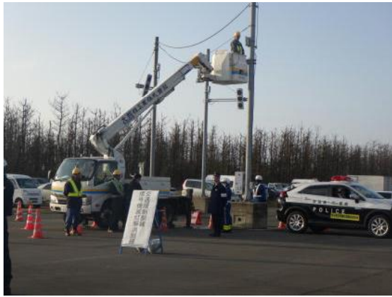
仮設信号機設置及び交通規制訓練
